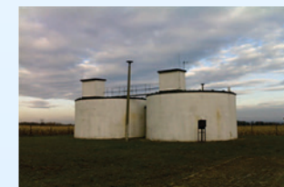
Zbiorniki wody czystej
