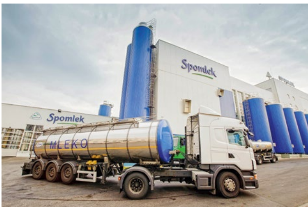
Zakład w Radzynie Podlaskim – na zdjęciu widoczne tankosilosy na mleko
