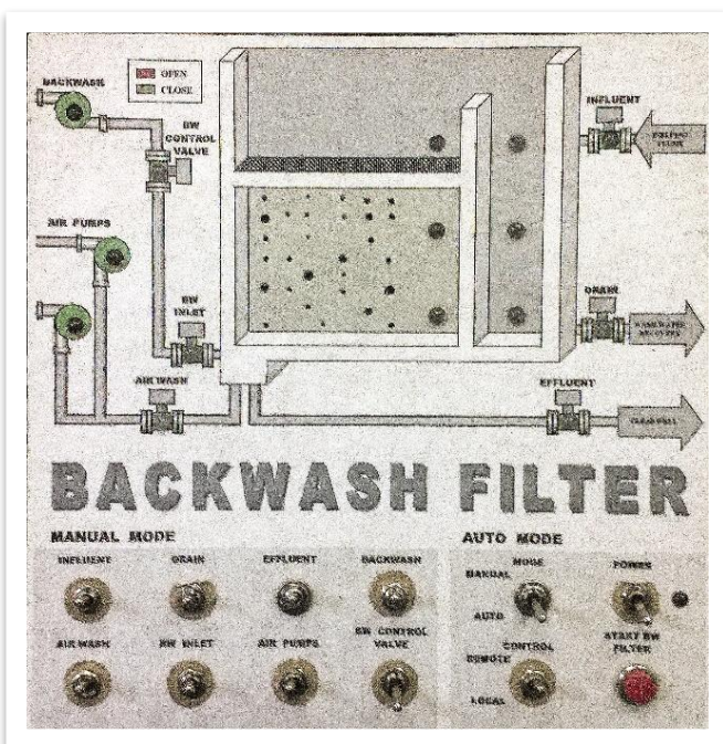
Rys3. Panel filtru wstecznego
